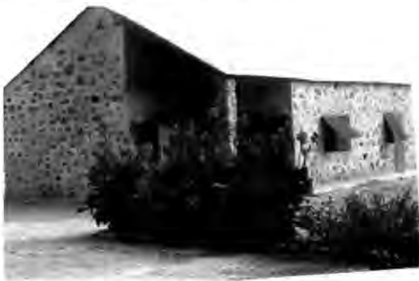
Unser erstes gemauertes Haus in Dagai
